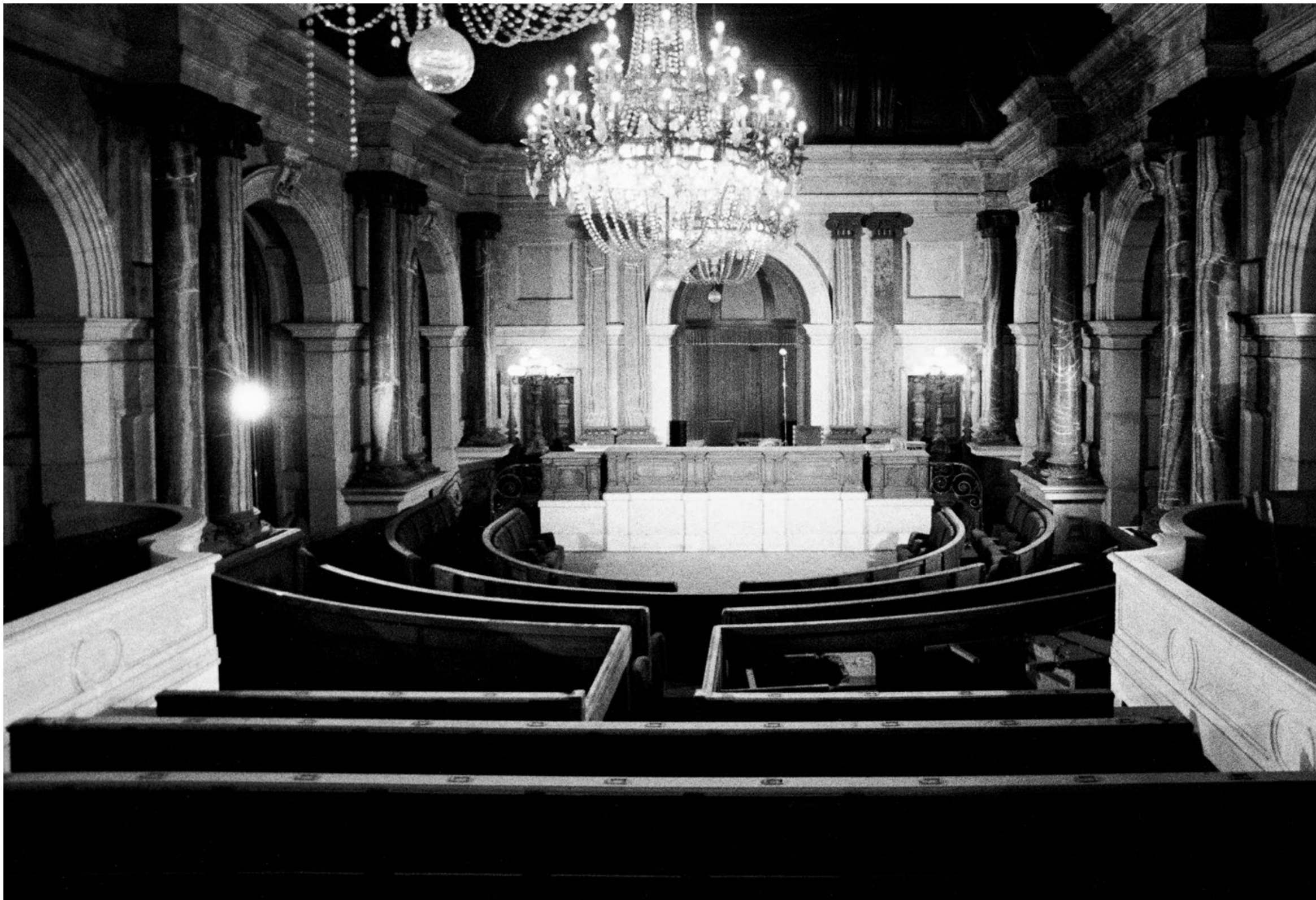
Obertura de les instal·lacions del Parlament de Catalunya per primera vegada des de la Guerra Civil. Barcelona, 1977
